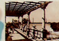
Pérgola piscina de Picaño
